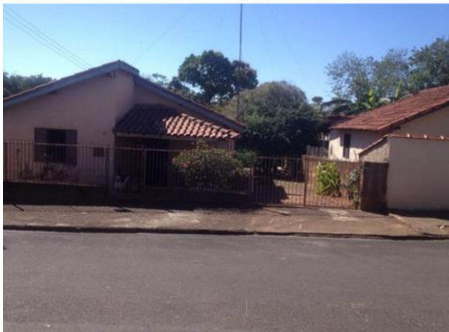
Imagem 11.11: Residências abaixo da “grade” da rua.
