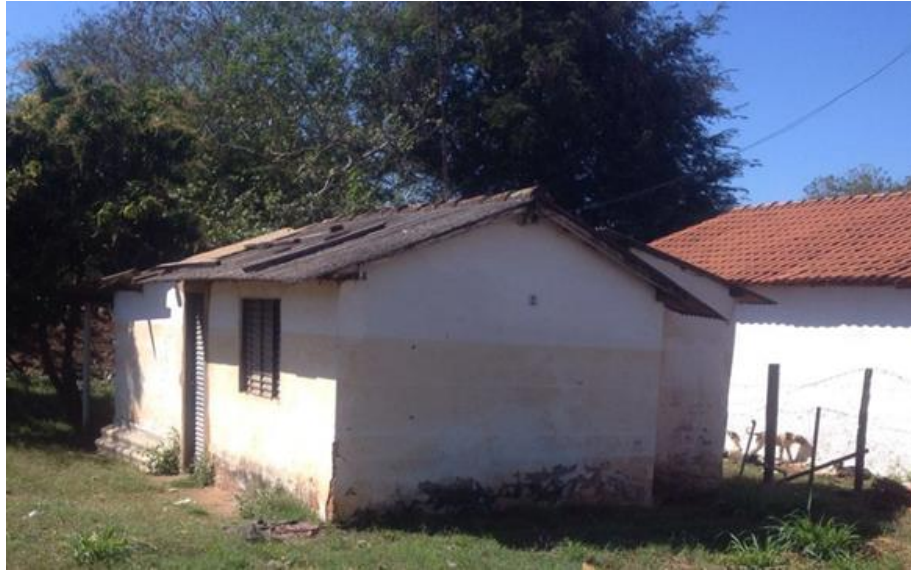
Imagem 11.12: Nível da inundação de 04 de janeiro de 2016.
