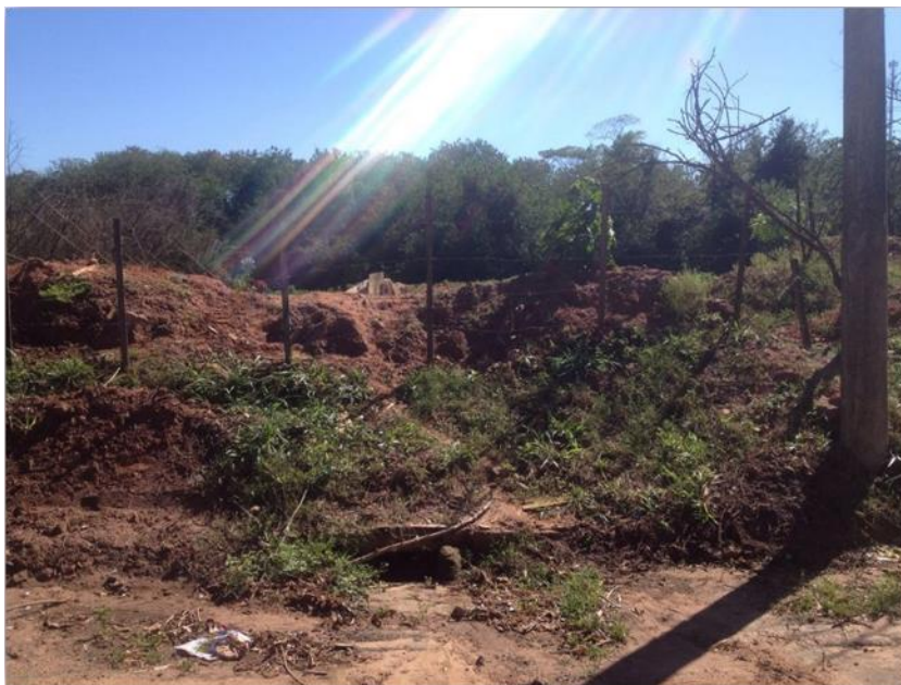
Imagem 11.5: Contenção em terra executada ao longo do Rio São Domingues.
