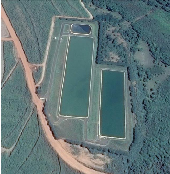
Figura 10.4: Estação de Tratamento de Esgoto de Catiguá. Fonte: Google Earth.
