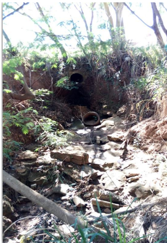
Imagem 11.2: Lançamento do talvegue do bairro Santa Isabel, após a travessia da estrada de ferro.
