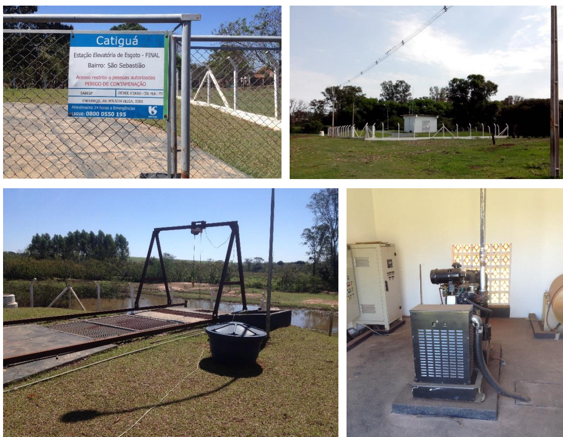
Imagem 10.2: Estação Elevatória e Esgoto Final de Catiguá.
