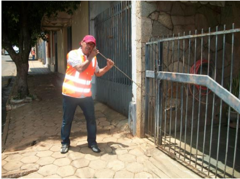
Imagem 9.12: Técnico verificando o cavalete sem adentrar a economia.
