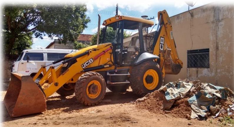
Imagem 8.8: Retroescavadeira utilizada na abertura de vala no Aterro municipal.
