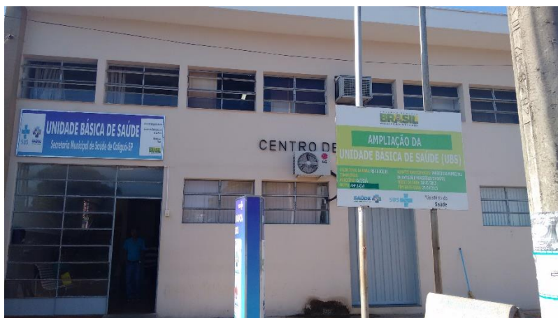
Imagem 8.24: Fachada da UBS de Catiguá.
