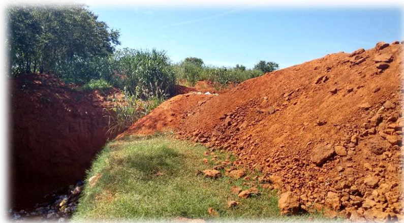
a) Resíduos e rejeitos dispostos na vala e, ao lado, a terra que será utilizada para cobrir o material ao final do dia.
