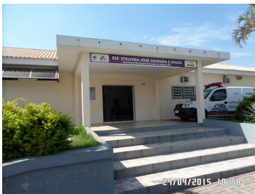
Imagem 8.25: Fachada da UESF de Catiguá.
