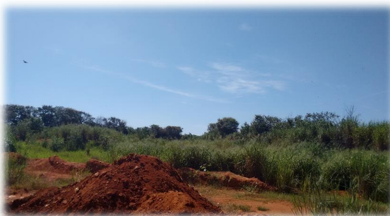
b) Área com cobertura vegetal corresponde às valas já encerradas. Imagem 8.9: Disposição de valas no aterro do município de Catiguá.
