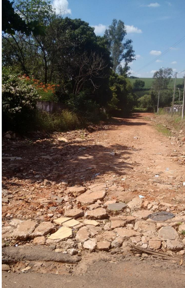
Imagem 8.36: Cobertura de via pública com RCC coletado em Catiguá.
