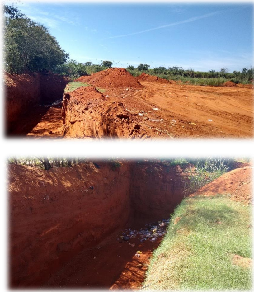
Imagem 8.6: Vala em atividade do aterro de Catiguá - SP.
