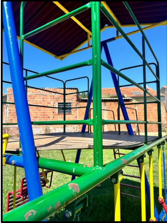
Assoalho improvisado com madeirite solto.
