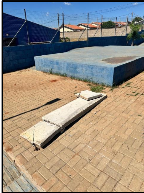
Assento de concreto quebrado.
