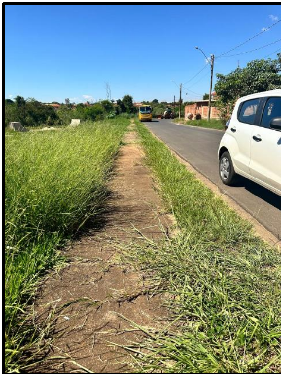
Mato alto ao redor da pista e na calçada.
